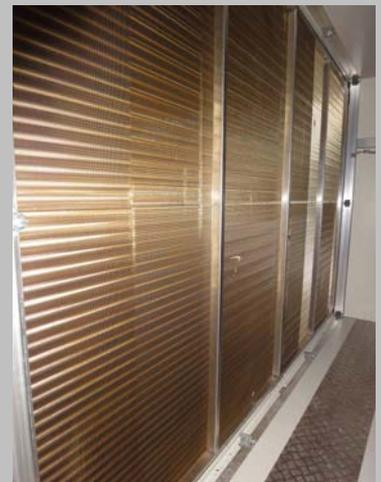
Neuer Wärmeübertrager der Hallenlüftungsanlage zur Abwärmenutzung
